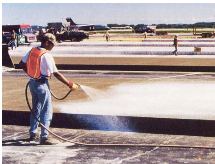
شکل ۴ روش عمل‌آوری با ماده شیمیایی غشایی
