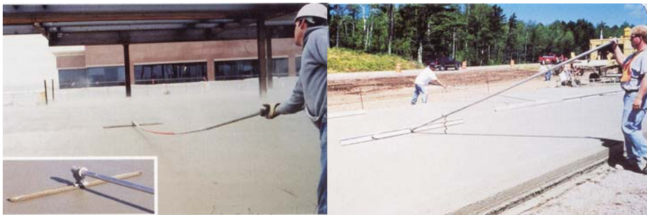
شکل ۳ تخته ماله‌کشی با تخته ماله دسته بلند
