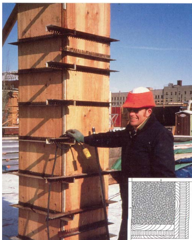
شکل ۵ استفاده از قالب‌های چند لایه برای عمل‌آوری در هوای سرد
