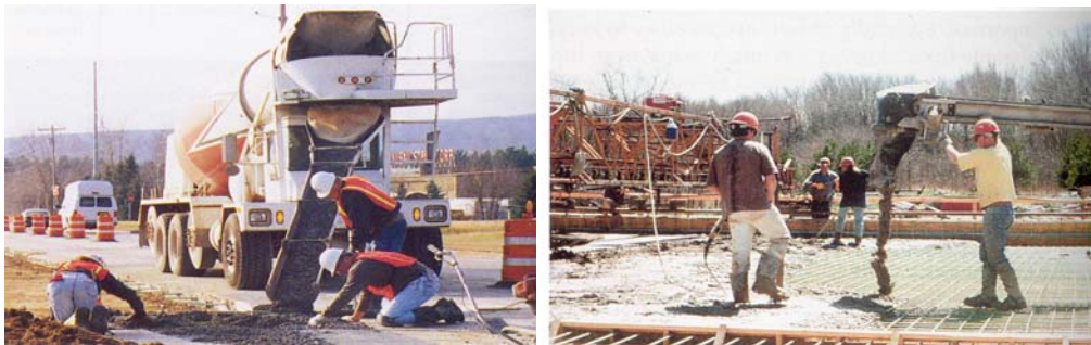
شکل ۲ ریختن بتن در نزدیکی محل مورد نیاز
