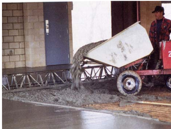
شکل ۳ روش صحیح ریختن بتن
